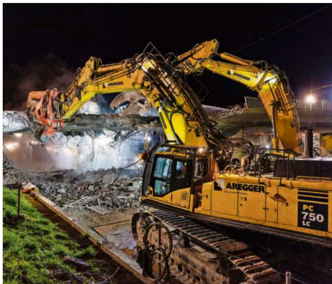
Zuerst die Geländer, dann die Fahrbahn: Die Überführung der Oberen Wangenstrasse über die Autobahn A1 wurde in der Nacht auf Sonntag mit schwerem Gerät abgerissen. Foto: Claudio Fornito (Astra)
