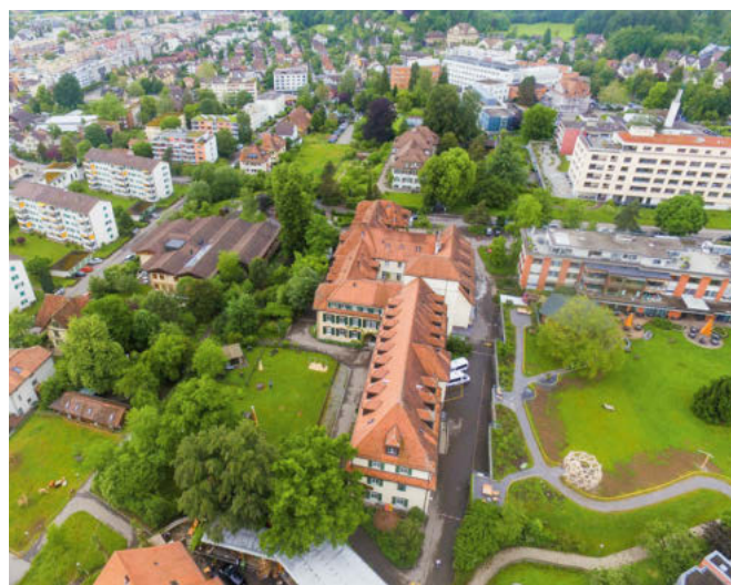
In der Mitte des weitläufigen Wagerenhof-Areals steht der über 100-jährige Altbau, der jetzt saniert wird. Foto: Wagerenhof
