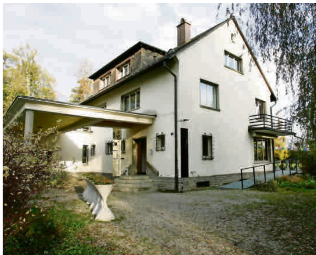
Sanierungsbedürftig: Die Villa am Aabach soll wieder «als Zeitzeuge in Erscheinung treten».
