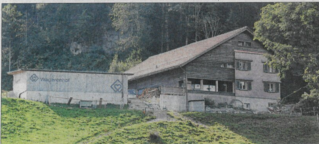
Der einstmalig vergandete Bauernhof wurde restauriert: Der Hof Bärloch ist heute eine Aussenstation des Wagerenhofs.
